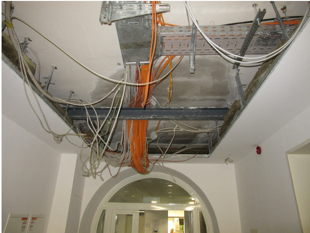
Foto 5 - Deckenhohlraum Flur EG
