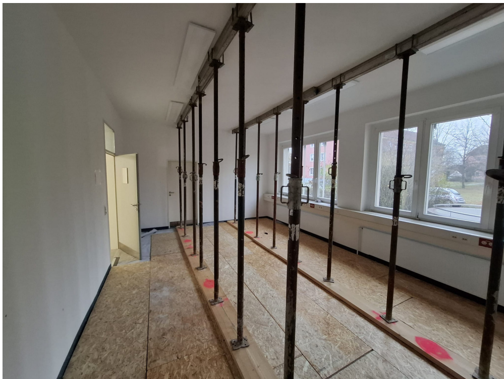
Foto 4 - provisorische linienförmige Deckenunterstützung
