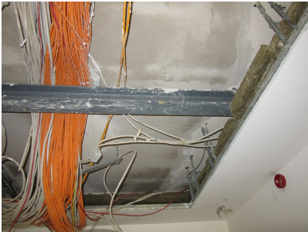
Foto 6 - Deckenhohlraum Flur EG
